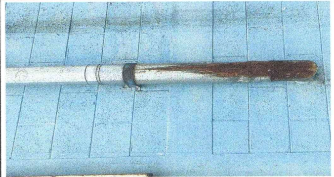
Foto 14: Sustitución de chimenea de metal
