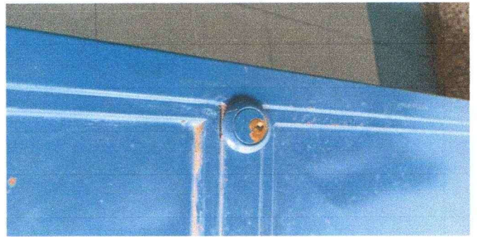
Foto 2: Sustitución de chapa.
