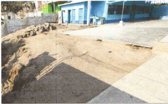
Foto 3: Reparación de piso de torta de concreto
