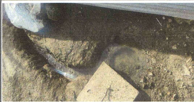
Foto 7: Sustitución de tubería PVC línea principal aguas negras.
