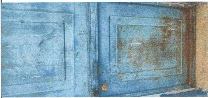
Foto1: Sustitución de puerta
