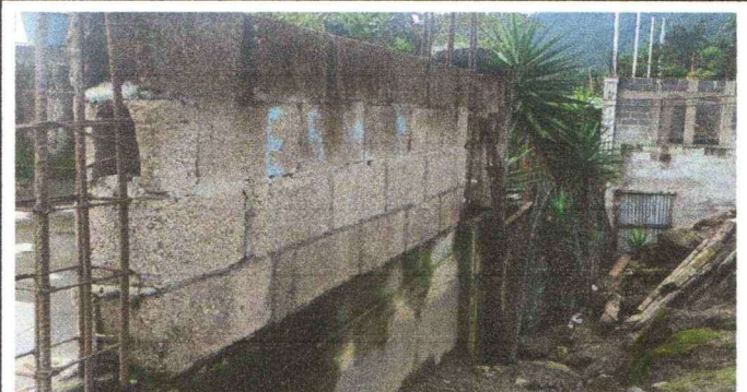
Foto 8: Reparación de muro perimetral de block y reparación de piso de torta de concreto.
