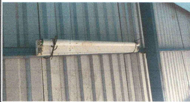
Foto 9: Sustitución de lámparas de 2x40 y sustitución de plafoneras
