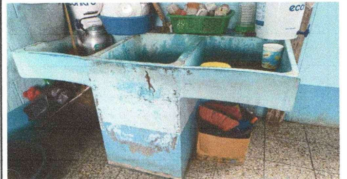
Foto 16: Sustitución de pila de cemento de dos lavaderos.
