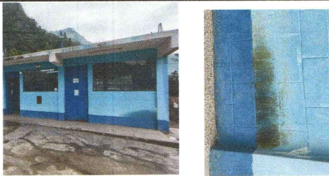
Foto 5: Pintura en muros exteriores e interiores
