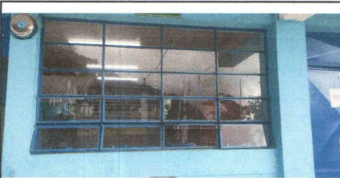
Foto 11: Fabricación e instalación de balcones de hierro en ventanas
